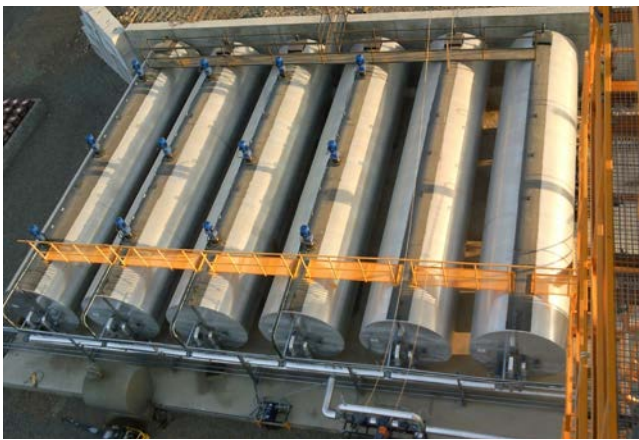
Horizontal bitumen tanks, thermal oil heated Serbatoi orizzontali per bitume, riscaldati ad olio diatermico
