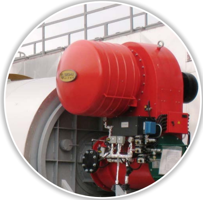
Highly efficient monobloc burner Bruciatore monoblocco ad alta efficienza
